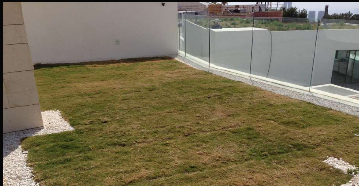
Cubierta vegetal Finestrat, 2020
