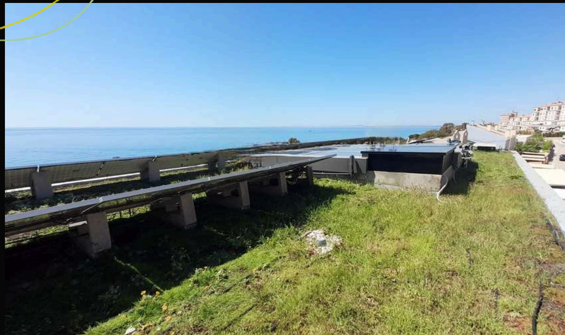
Cubierta vegetal Alicante, 2020
