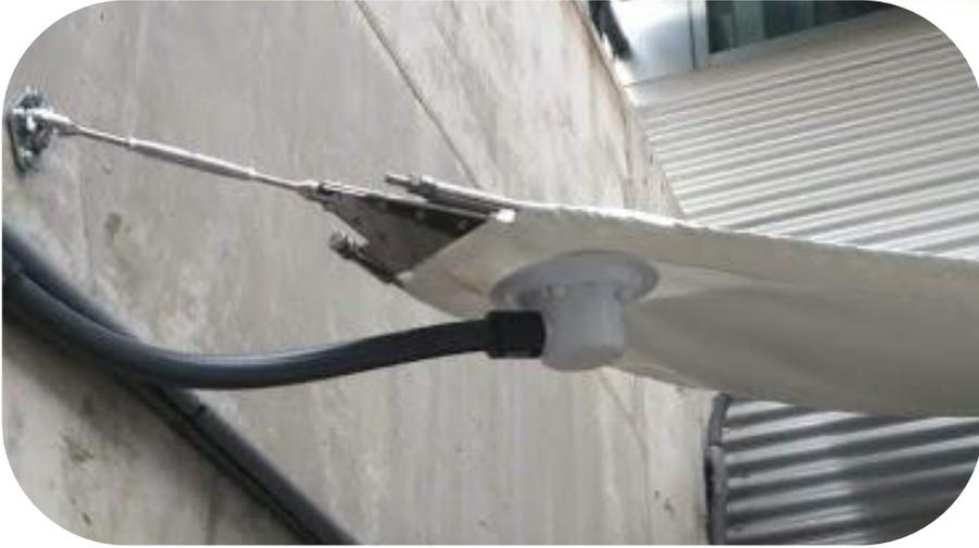
**Conexión del desagüe** al punto más bajo del toldo para recoger el agua sobrante.
