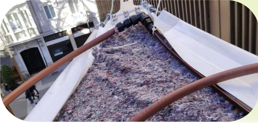
**Conexión del sistema de riego** a la toma de abastecimiento de agua.
