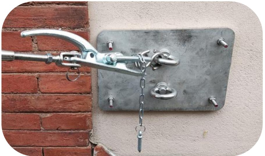
**Anclaje de las tres esquinas** a los soportes, tensando la estructura por completo.
