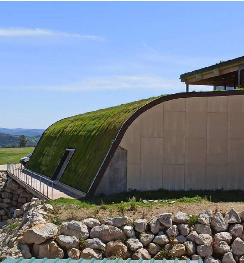
El sistema Rizoma es una **cubierta vegetal no transitable muy ligera y de poco espesor**, la cual se puede colocar en superficies planas o inclinadas debido a la adherencia del sustrato a las capas inferiores del propio sistema.
