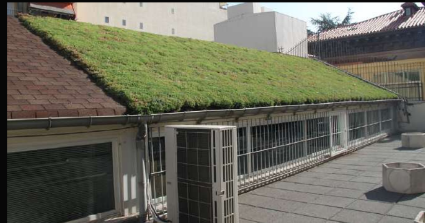
Cubierta vegetal Madrid, 2018
