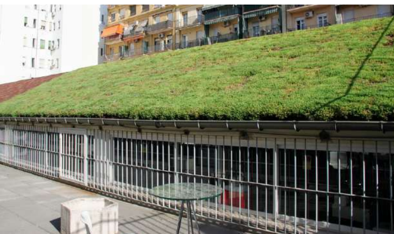
Cubierta vegetal Madrid, 2018
