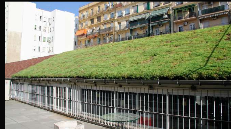
Cubierta vegetal Madrid, 2018
