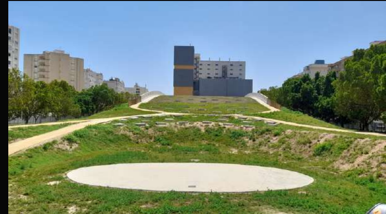
Cubierta vegetal Gandia, Valencia, 2017
