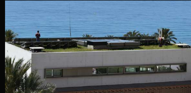
Cubierta vegetal Santa Pola, Alicante, 2020
