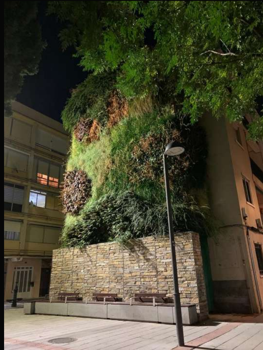
Vertical garden Azuqueca de Henares, 2017.
